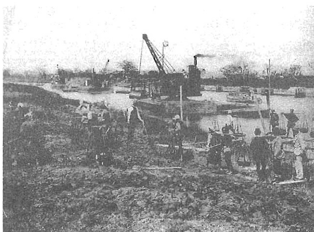
写真-3 大阪築港工事(明治31年竣工)
